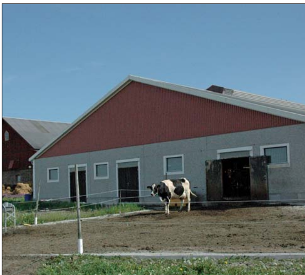
Hårdgjord yta av betong utanför stalldörren.
