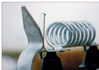
Åskskydd minskar risken för skadliga överspänningar.
